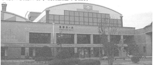
会場となった盛岡市市民文化会館姫神ホール
